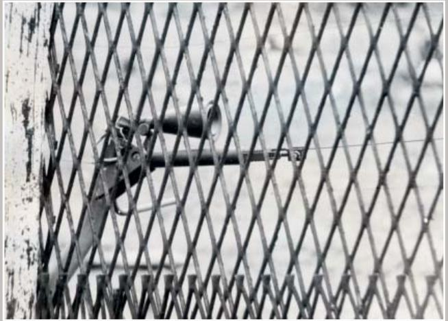
*Der Selbstschussapparat, die Splittermine SM 70*
